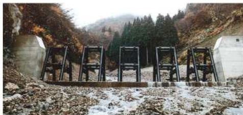
スリット型治山施設(谷止工)
