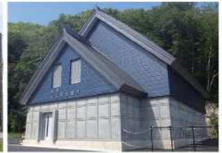
上百瀬発電所
