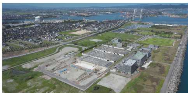
神通川左岸浄化センター
