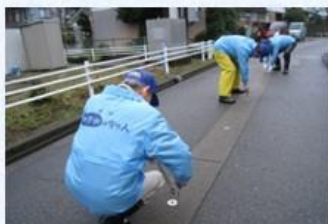
制御盤や散水ノズルの調整
