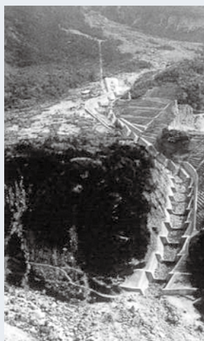
Under construction (1933) 施工中(1933年)
