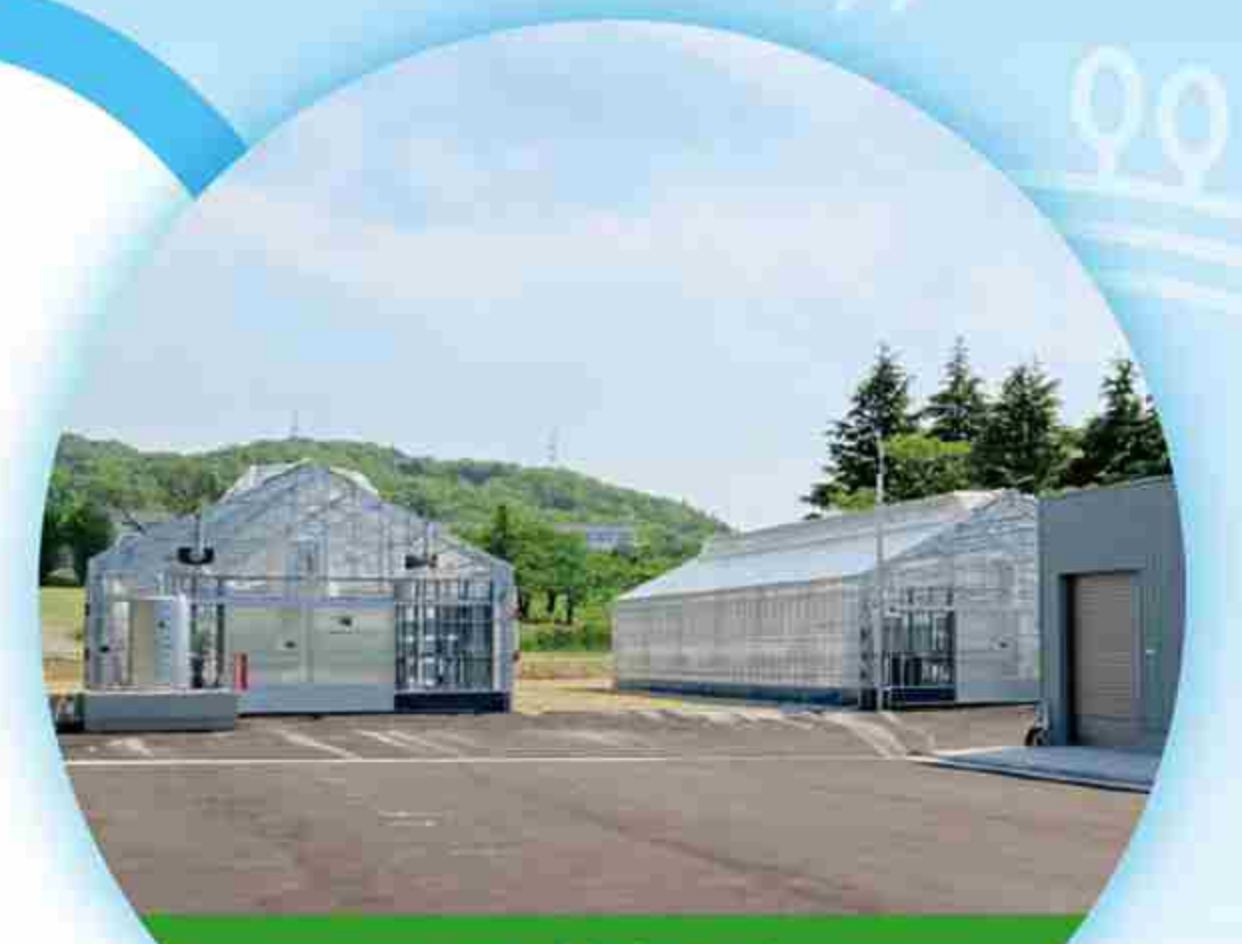
環境制御型園芸ハウス等外観
