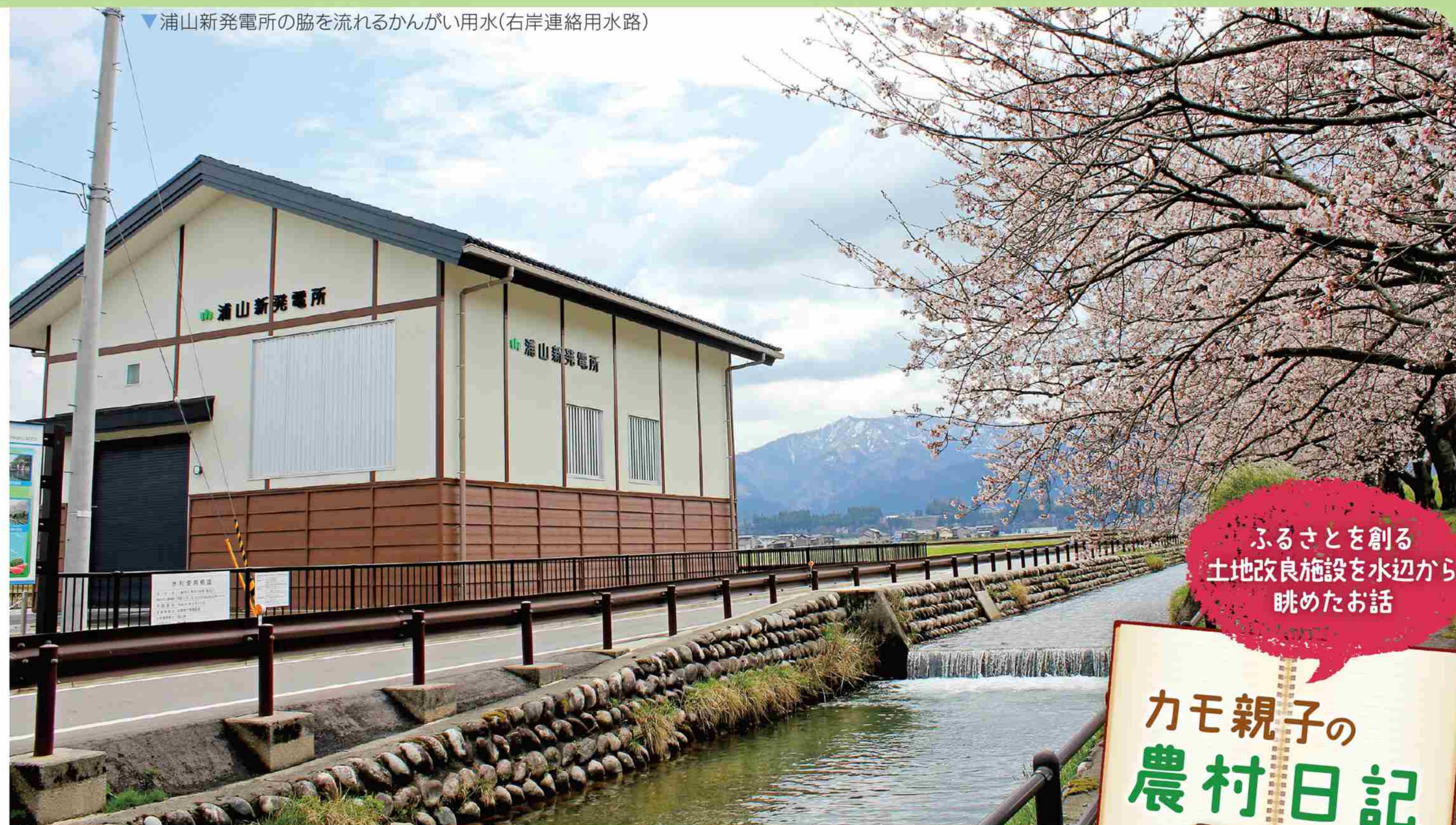
▼浦山新発電所の脇を流れるかんがい用水(右岸連絡用水路)
