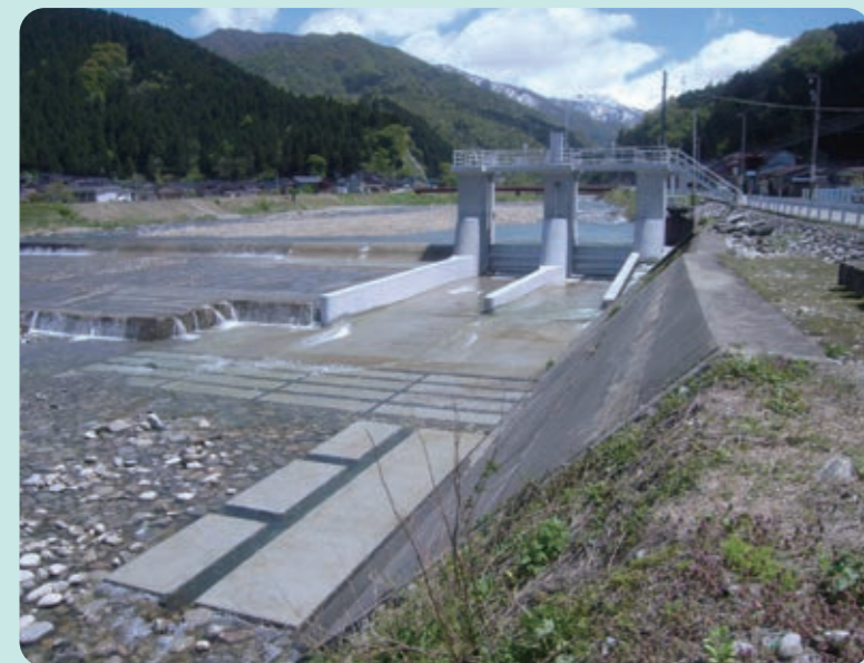
整備が進められている小川頭首工
