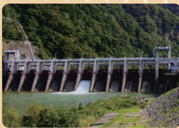
庄川用水合口堰堤
