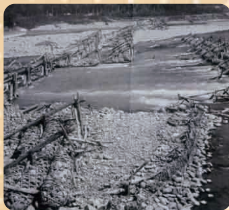
若林口用水旧取入堰の一部(昭和11年)
