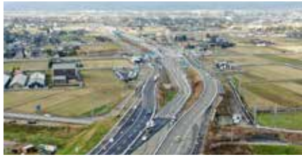
高岡環状道路の整備(高岡市上伏間江～佐野)
