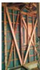
木造住宅の耐震改修工事
