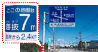
既設道路標識柱への海拔等の表示
