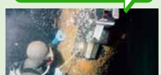
港湾岸壁の防食機能維持
