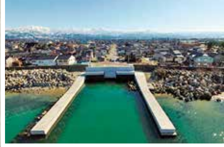
市街地の浸水被害を防ぐため、放水路の整備を進めています！
