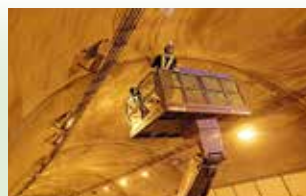
トンネル点検
