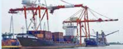
国際コンテナ船での輸出入(新湊地区)
