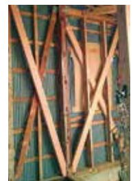
木造住宅の耐震改修工事
