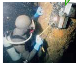
港湾岸壁の防食機能維持
