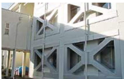
耐震改修（衛生研究所）
