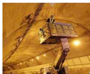
トンネル点検
