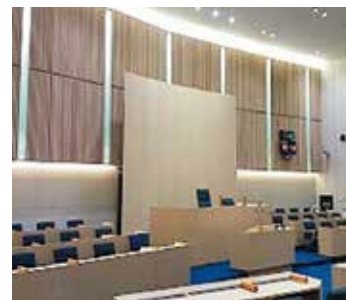
県産材木材壁面ルーバー (富山県議会議事堂)
