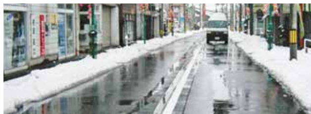
消雪施設の整備
