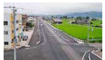
県道 砺波福光線 【南砺市吉江～遊部】
