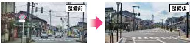
電線共同溝整備による無電柱化【国道415号(氷見市中央町地内)】
