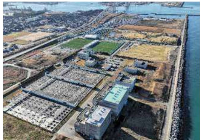
神通川左岸流域下水道 神通川左岸浄化センター (射水市海竜町地内)
