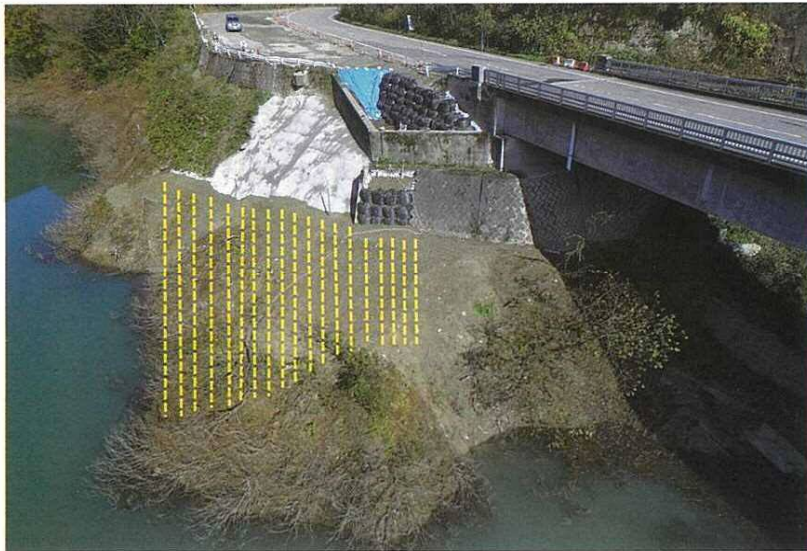
(株)村尾地研施工の「一般国道 472 号道路総合交付金 (防災・災防) 抑止杭工その 2 工事」
