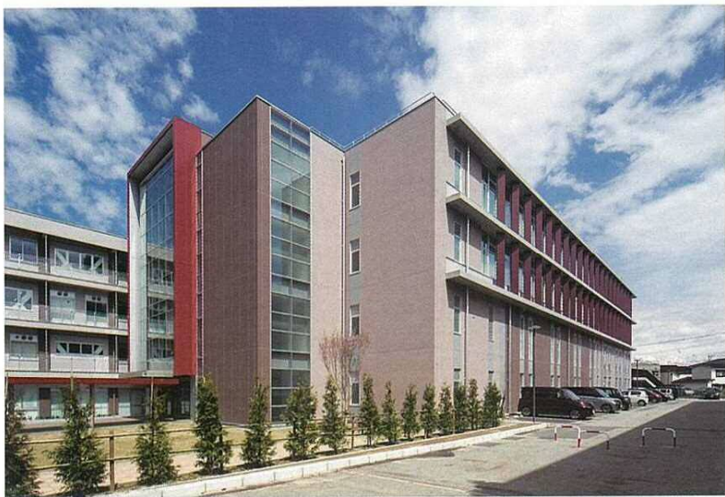
日本海建興・タカノ建設・石坂建設富山県立大学看護学部教育棟 新築工事共同企業体施工の「富山県立大学看護学部教育棟新築工事」
