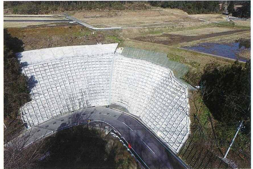
朝野工業(株)施工の「一般県道坪野湯上線道路総合交付金 (防災・災防) 法枠工工事」
