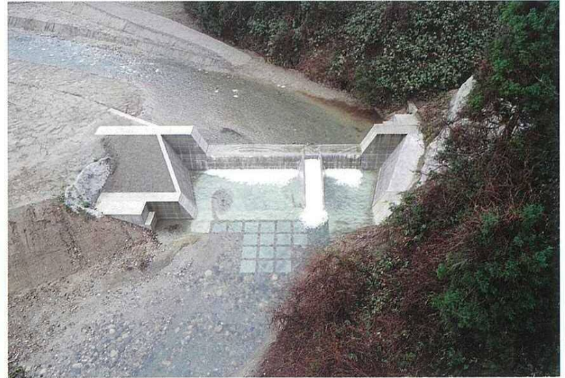
新栄建設(株)施工の「白岩川水系白岩川河川災害復旧(目桑工区) 床固工工事」
