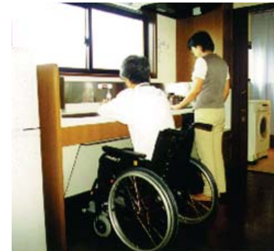
▲ 立っている人が楽な高さは、車いす使用者には使いづらい
