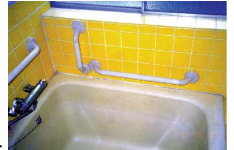
▶ 浴槽部分に垂直・水平手摺を設置
