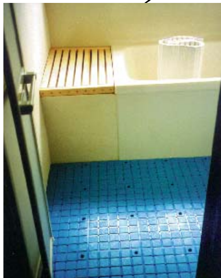
▲腰掛け部分を設置
