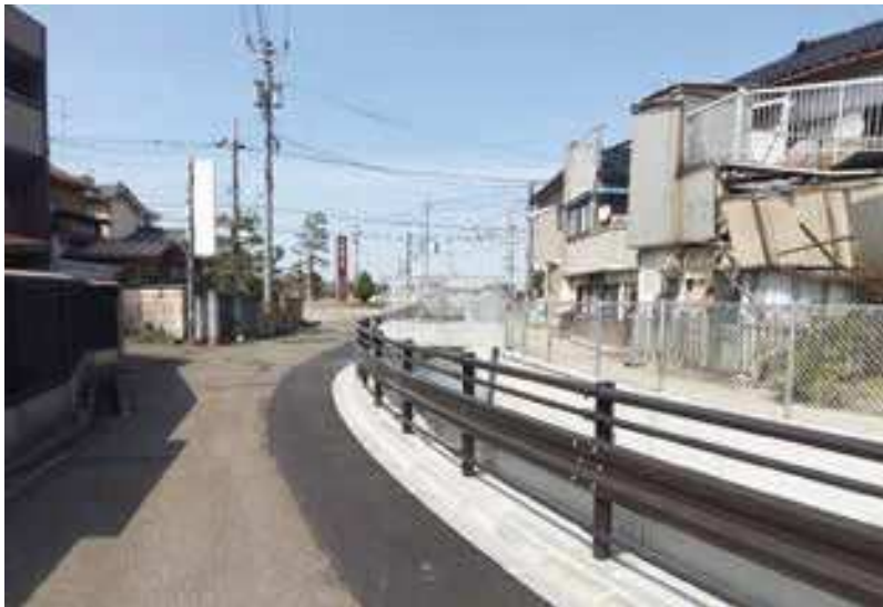
(株)得能組施工の「農地防災庄川左岸三期地区若林口用水路第 12 工区工事」
