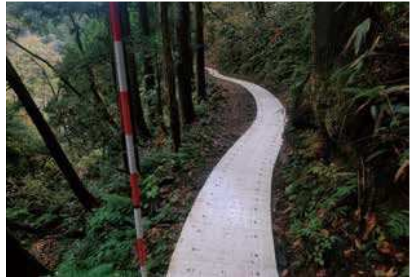
(株)森長組施工の「用排水施設整備鉢地区鉢用水路第5工区工事」
