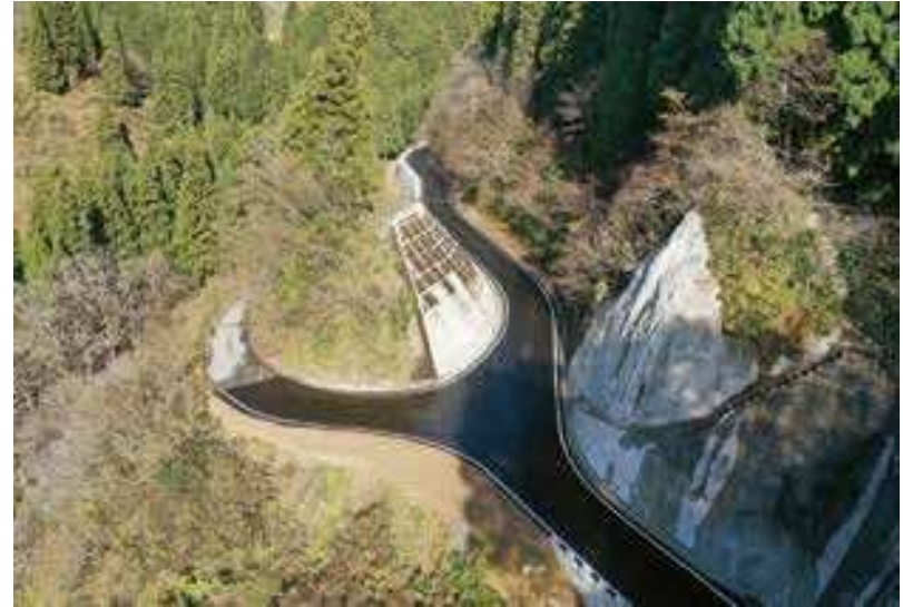
(株)ユアネクス施工の「県営林道開設別又嘉例沢線中ノ又谷工区 (その2) 改築工事」
