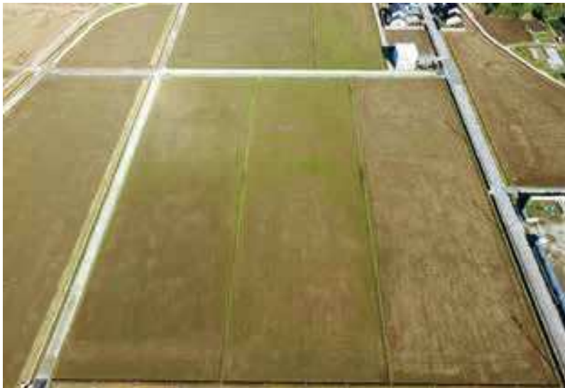
長崎土石(株)施工の「ほ場整備浜黒崎地区第6工区ほ場整備工事」
