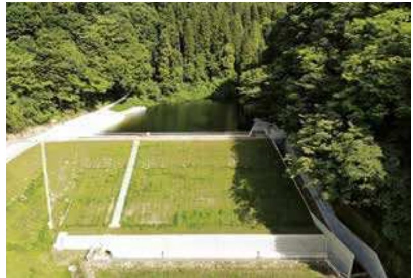
(株)丸三国土建設施工の「県営農村地域防災減災事業谷内白山池地区谷内白山池堤体改修工事」
