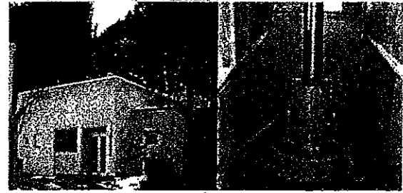
【発電所建屋水車】
