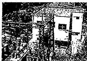
【小鹿第一発電所】
