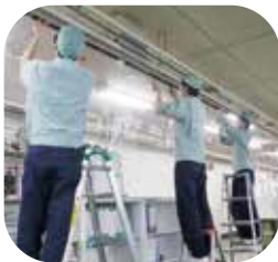
LED照明の取り付けを している様子
