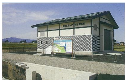
仁右エ門用水発電所 [460kW] (立山町)
