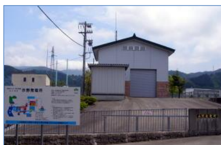
示野発電所 [550] (砺波市)
