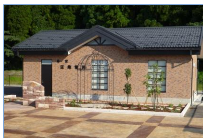
庄発電所 [190kW] (砺波市)
