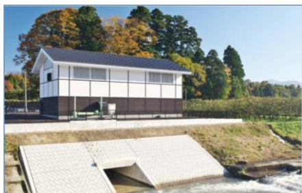
山田新田用水発電所 [520kW] (南砺市)
