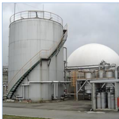
食品リサイクル工場メタン発酵槽とガスホルダ
