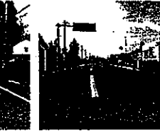
水の浸透による消雪装置未設置 路線東端池沼保護等
