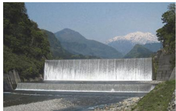
常願寺川砂防施設（本宮堰堤）
