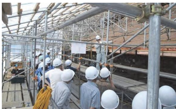
文化財建造物保存修理現場の公開
