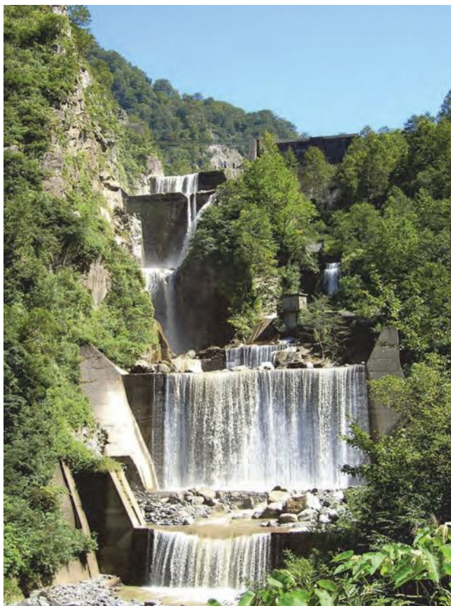
常願寺川砂防施設（白岩堰堤）
