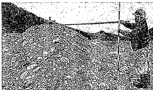
早月川上流部の砂利採取現場での土量調査(高さ検測)
