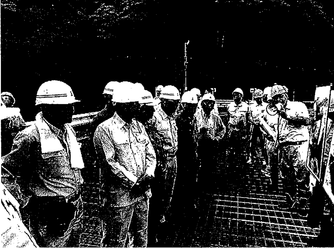
利賀百瀬地区土砂崩れの現場 仮説橋の上から視察
