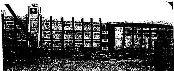
よつば小学校建設現場 本江小グラウンド
