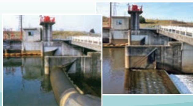
▲郷川頭首工 田に水が必要な時期には川の水をせき止めて下条用水へ取り入れ(写真左)、耕作しない期間はせき止めずに川の水はそのまま流れていきます(写真右)このほか、大雨等により上流水位が上がると堰は自動で倒れ、洪水被害を防ぎます。
