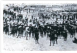
▲開削工事の様子
