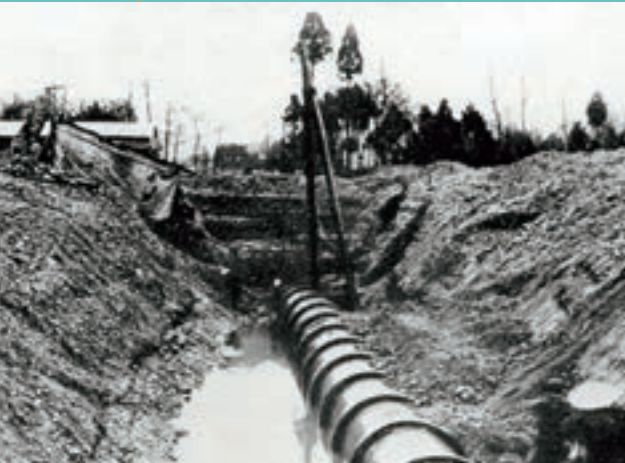
▲逆サイフォン部分のヒューム管敷設の様子
