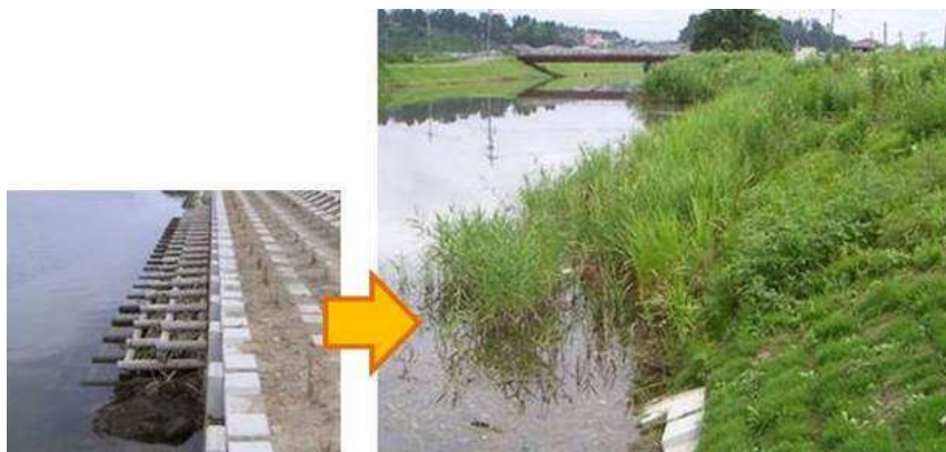
多自然川づくりの事例 (仏生寺川の植生工・木工沈床工（氷見市）)
