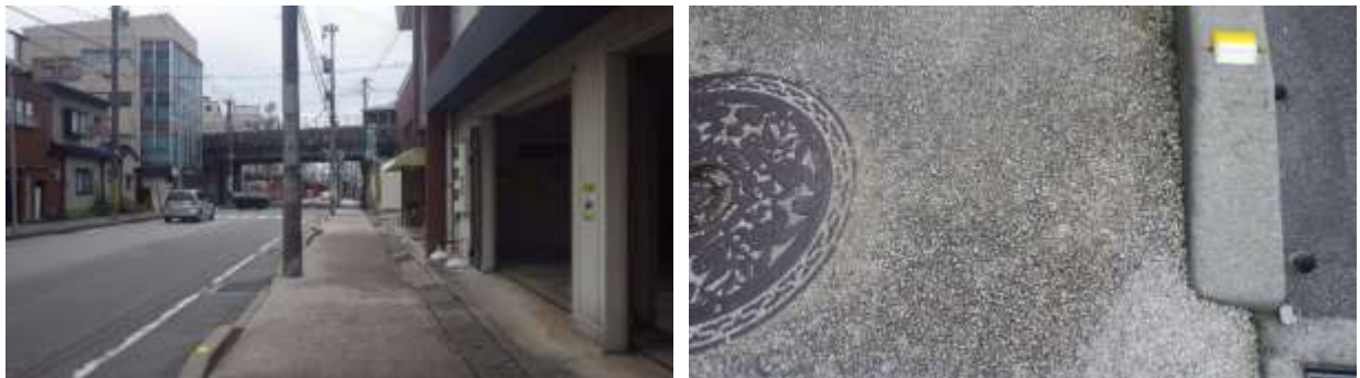
透水性舗装（魚津市友道地内県道 322 号線（大海寺新本町線）歩道）
