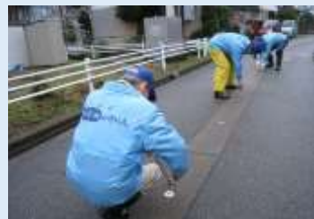
消雪ノズルの点検
