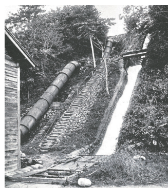
Power plant Okubo Station 大久保発電所 (『富山県写真帖』より) (富山県公文書館提供)
