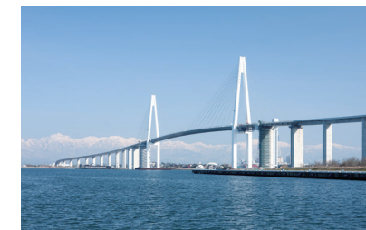
Shinminato Ohashi 新湊大橋
